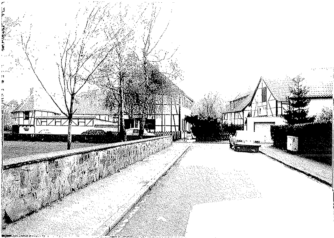
Nordwall im Bereich Einmündung Brandstraße
