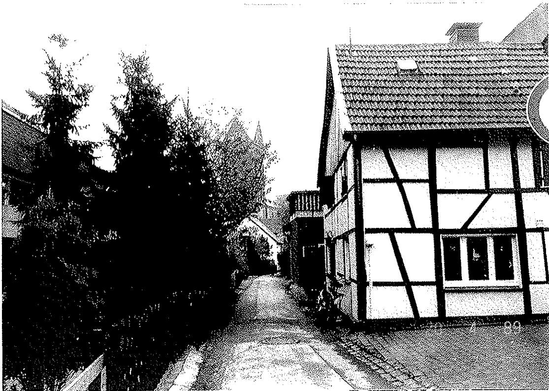
Nordwall von W
