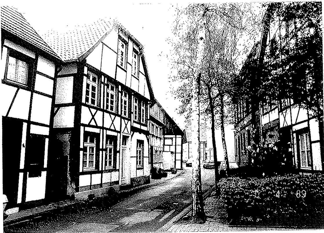
Untere Brandstraße von O
