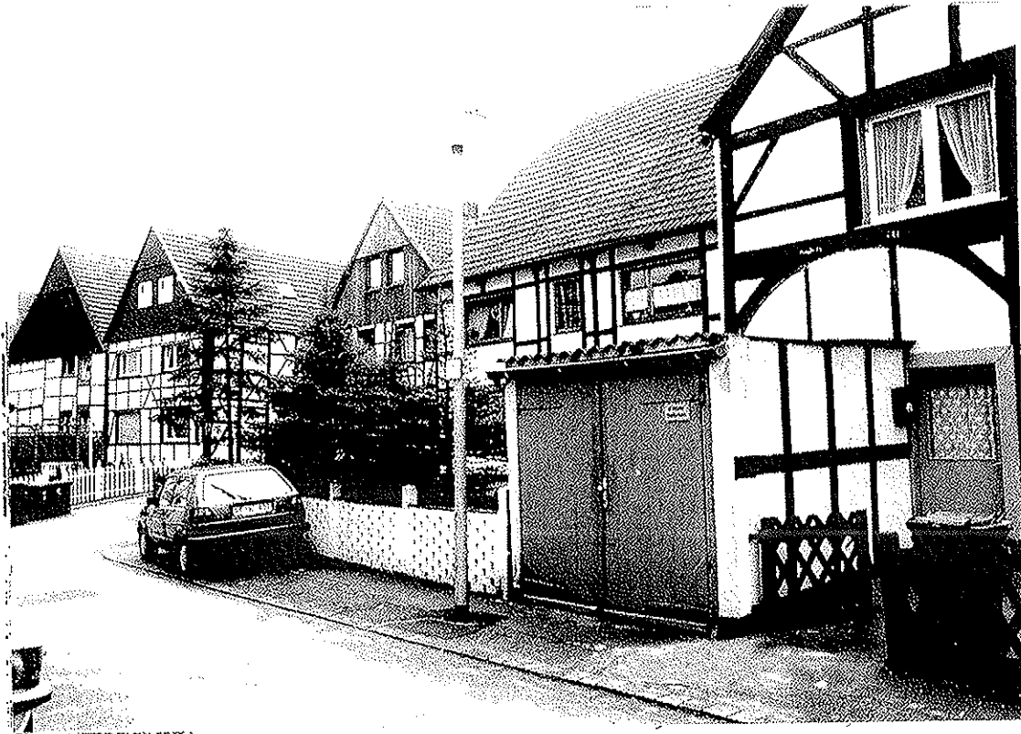
Häuserzeile zwischen Nordwall und Brandstraße
