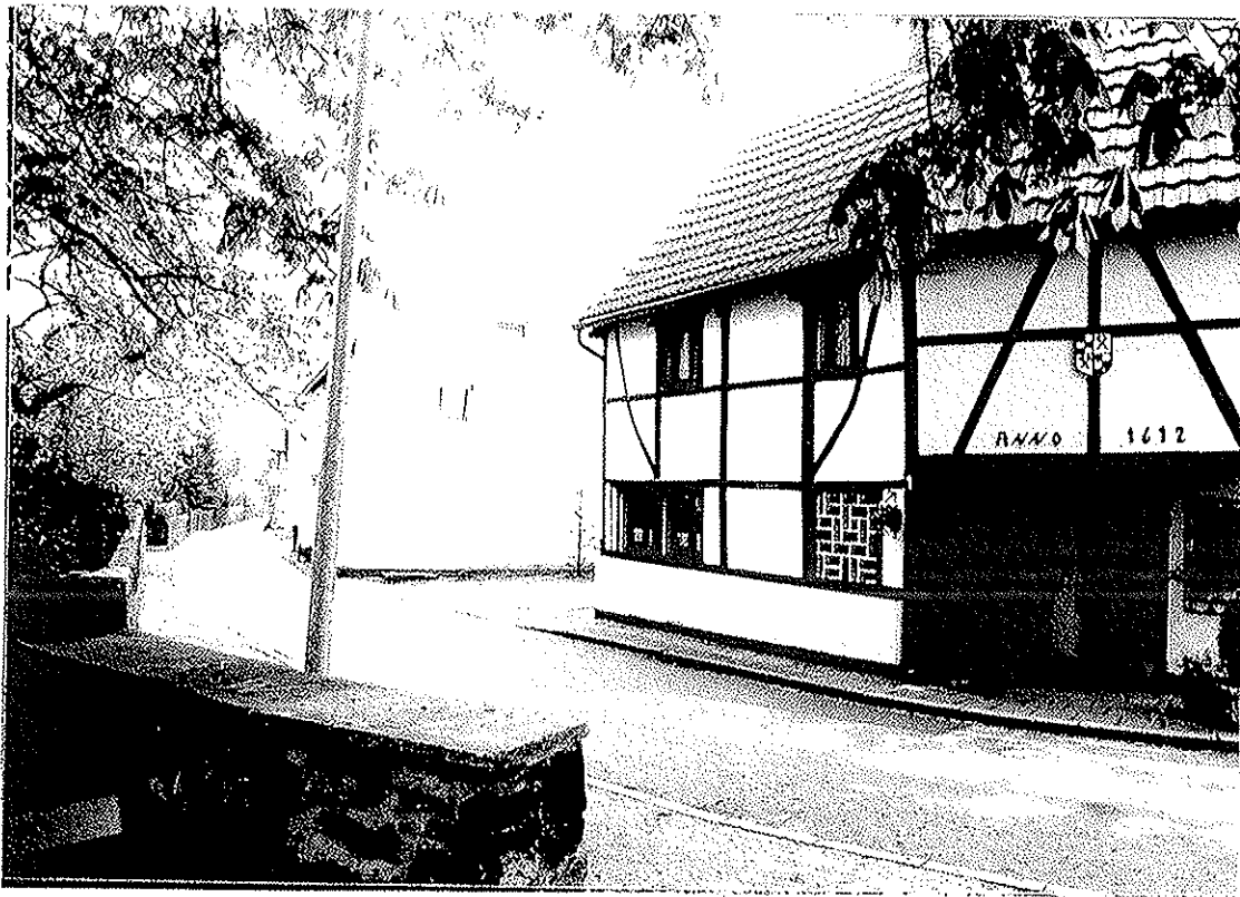
Nordwall von W
