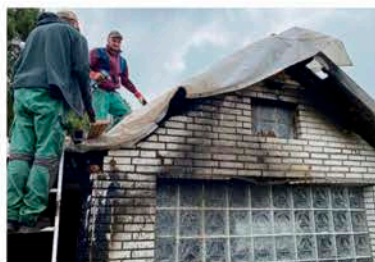
Wenige Stunden nach dem Brand: Aufräumen und erstmal das Dach einer schwer lädierten Hütte abdichten steht im Kleingartenverein „Gut Grün“ in Herten-Scherlebeck auf dem Programm.
