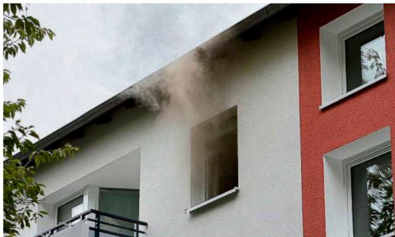
Rauch steigt aus einer Wohnung in Herten-Bertlich auf.
