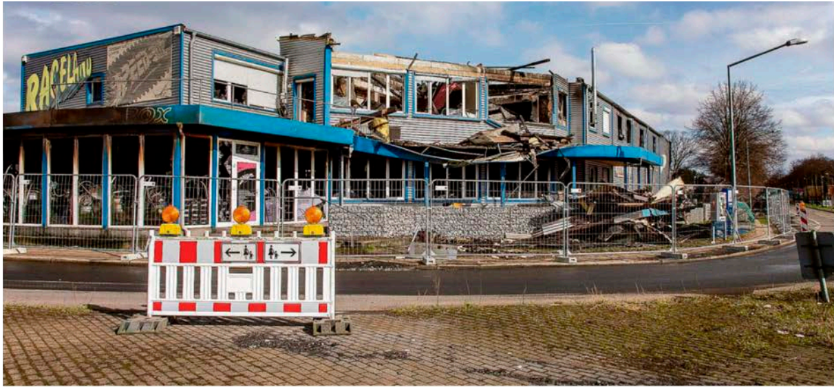
Nur noch Trümmer: die verkohlten Überreste des Gebäudes an der Hohewardstraße.
