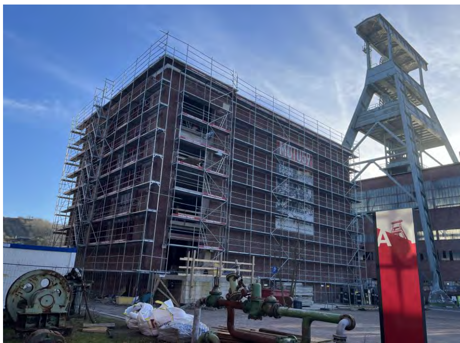
Maschinenhaus Nord ehem. Zeche Ewald
