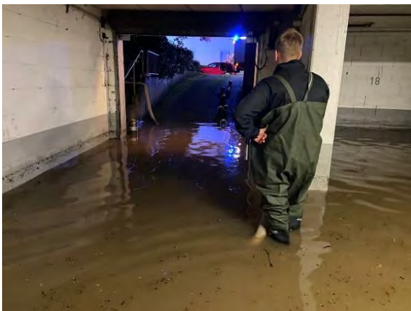
Auspumpen einer Tiefgarage
