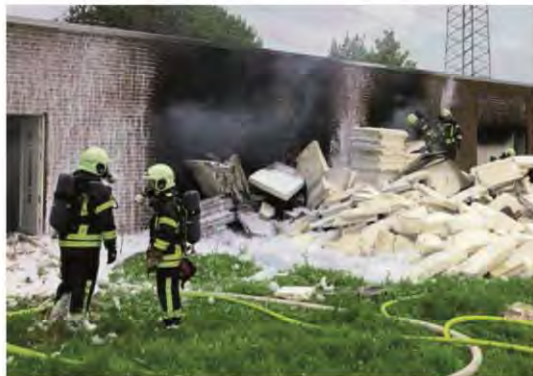
Die Flammen greifen auf große Mengen Styroporplatten über, die vor dem Gebäude liegen.
