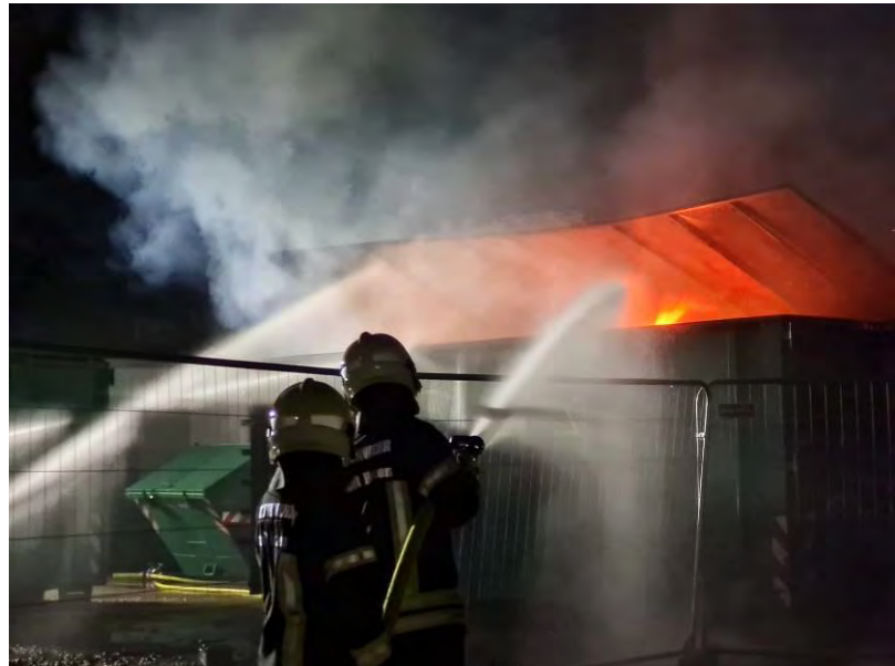
Lithium Batterien brennen in einem Container
