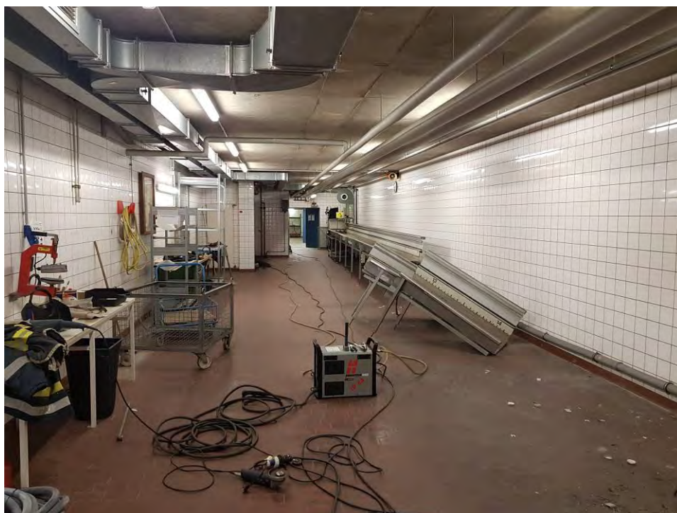
Abbau der Altanlage
