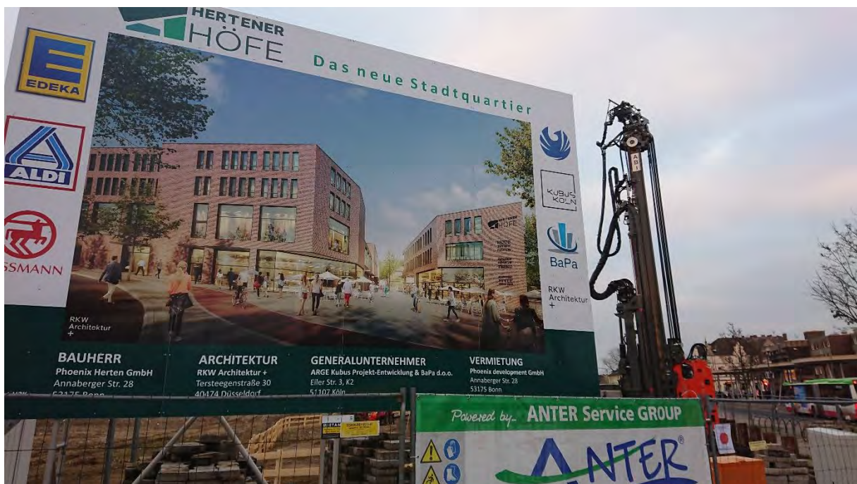
Neubaumaßnahme „Hertener Höfe“
