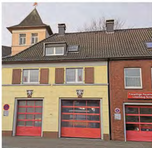
Das marode Feuerwehrhaus des Löschzugs Scherlebeck an der Richterstraße ist in die Jahre gekommen.
