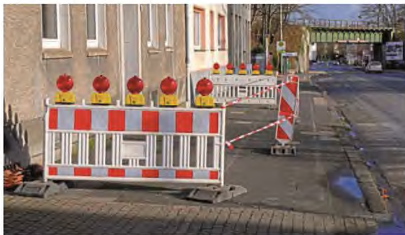
An der Kaiserstraße hatten sich Dachziegel an einem Wohnhaus gelöst, der Bereich ist seitdem gesperrt.
