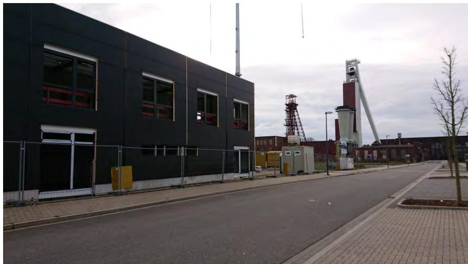
Neubau Gewerbegebäude auf dem Zechengelände Schlägel und Eisen
