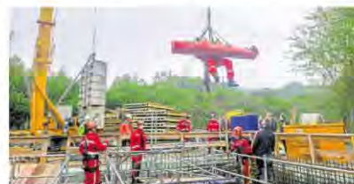
Auf einer Baustelle der Emscher-Genossenschaft an der Hohewardstraße holen Höhenretter am 16. September einen verletzten Arbeiter aus einem 16 Meter tiefen Schacht.
