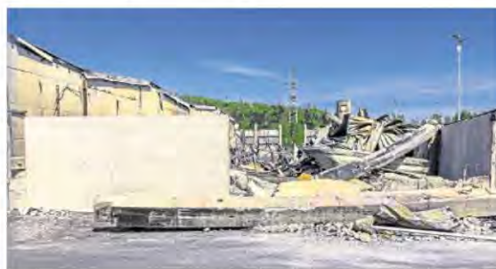
Am Logistikstandort von Hagebau laufen Aufräumarbeiten.
