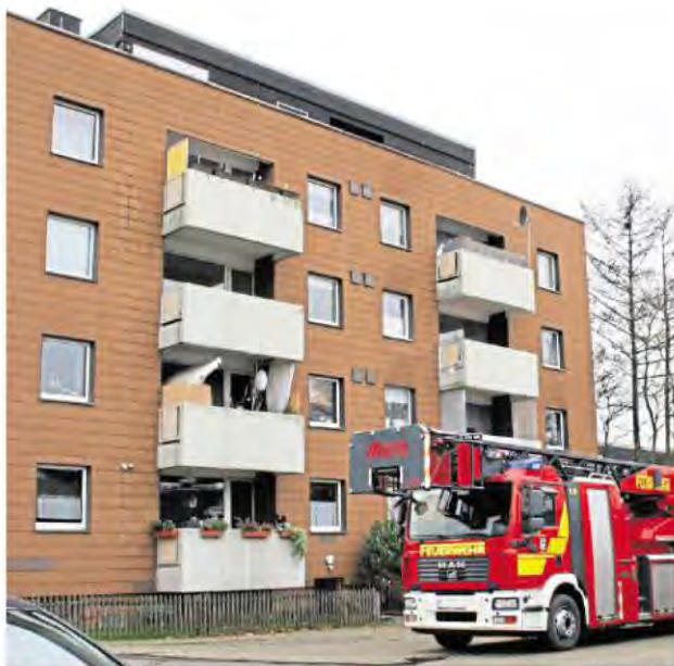
Auf dem Balkon dieser Penthouse-Wohnung an der Mühlenstraße brach das Feuer aus. —FOTO: WOLFF
