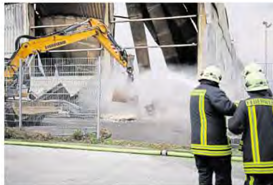
Ein Bagger riss die Wand einer Baustoff-Lagerhalle ein, damit die Einsatzkräfte weitere Glutnester im Inneren bekämpfen können.
