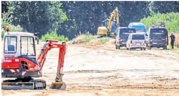
Auf der Thyssengas-Baustelle bereitet der Kampfmittelbeseitigungsdienst die Sprengung vor. —FOTO: JÖRG GUTZEIT
