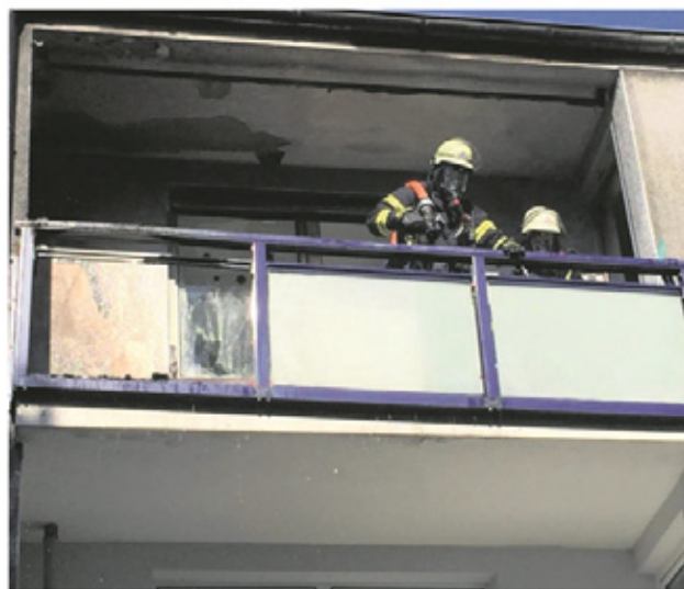
Einsatzkräfte sichern den Balkon, auf dem das Feuer ausgebrochen ist. Eine der beiden Scheiben des Kinderzimmerfensters ist geplatzt.
