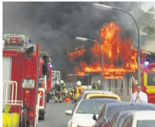
Dachdecker-Arbeiten führen am 29. September 2016 zum Brand einer Schreinerei an der Steverstraße. —FOTO: ARCHIV
