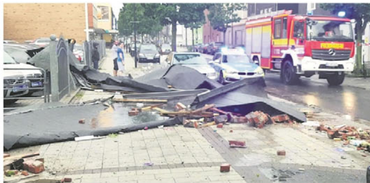
An der Bahnhofstraße sind Teile eines Flachdachs von einem Haus gestürzt und haben große Mauerstücke mitgerissen. Wie durch ein Wunder wurde niemand verletzt.
