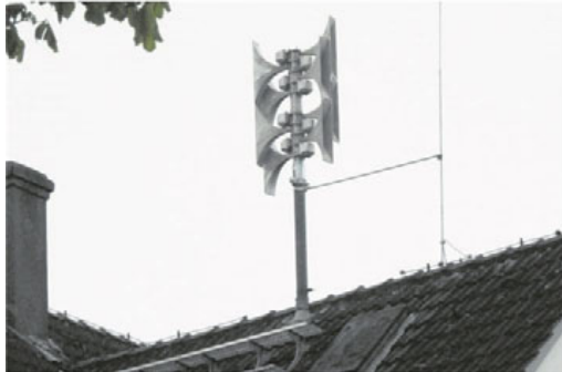
Die neuen Sirenen – hier auf der Comeniuschule – sehen nicht mehr wie Pilze aus, die das Signal mechanisch erzeugen. Es sind starke Lautsprecher. —FOTO: MARTIN PYPLATZ
