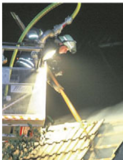
Ein Feuerwehrmann öffnet das Dach zum Löschen.
