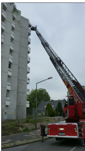
...Entkernung und Grundsanierung eines Wohngebäudes mit 32 Wohneinheiten
