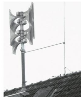
Die neuen Sirenen – hier auf der Comeniuschule – sehen nicht mehr wie Pilze aus, die das Signal mechanisch erzeugen. Es sind starke Lautsprecher. —FOTO: PYPLATZ
