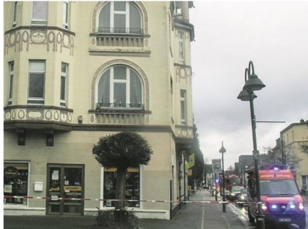
Vom Dach dieses Hauses an der Ewaldstraße in Herten-Süd reißt der Sturm einen Schornstein. Die Feuerwehr sperrt den Bereich großräumig ab.
