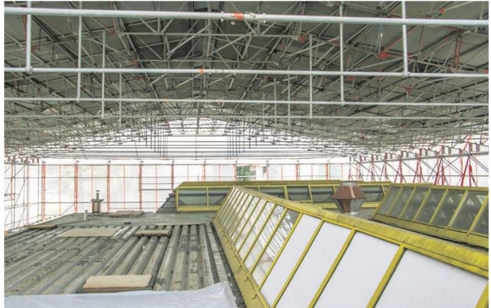
Eine gewaltige Dach- und Gerüstkonstruktion über der Feuerwache schützt die Handwerker und verhindert, dass es ins Gebäude regnet. Die alte Dämmung und die Bitumenbahnen wurden bereits abgetragen. Als nächstes werden die gelben Fensteraufbauten entfernt, denn deren Anschlüsse sind undicht.
