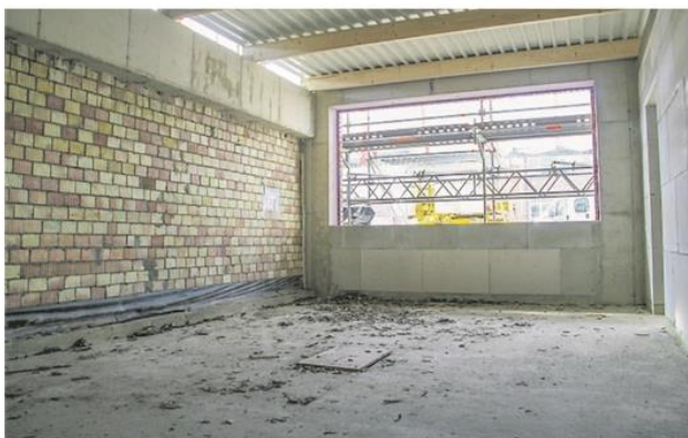
Die Atemschutzwerkstatt – hier einer der neuen Räume – befindet sich noch im Rohbau-Zustand.
