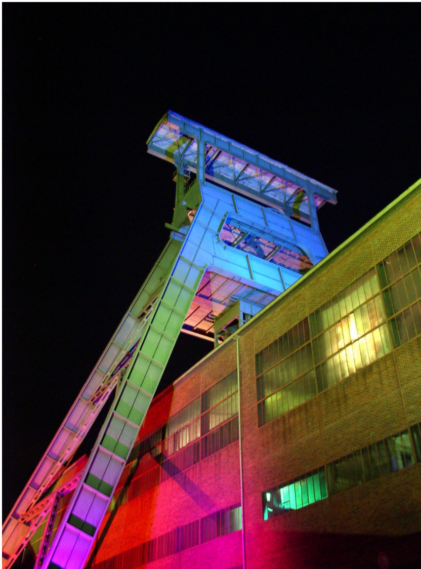
Extraschicht 2018 auf dem Gelände der ehemaligen Zeche Ewald
