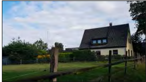
Abb. 4-5: Bebauung am westlichen Siedlungsrand von Scherlebeck
